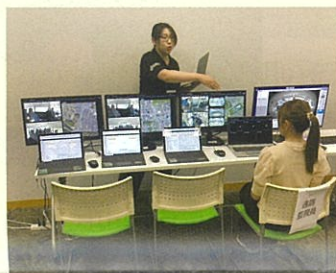
遠隔監視システムの様子
