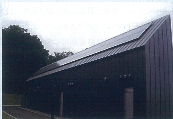
モエレ沼公園 雪氷熱エネルギー利用システム
